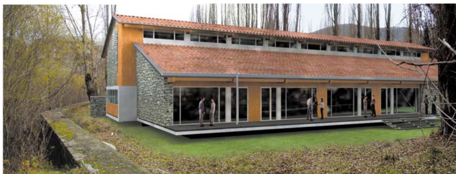
Sede de la ECEM en construcción
